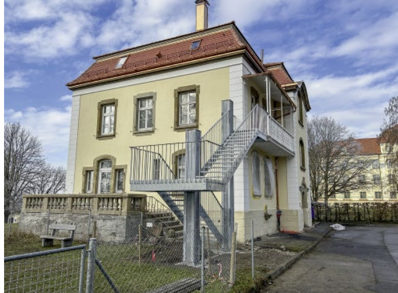
Die neue Außentreppe an der Kita Forsthaus dient als zweiter Rettungsweg im Ernstfall.
