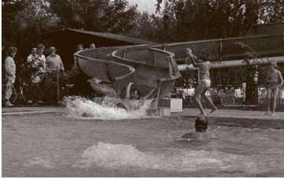
Einweihung der Rutsche im Freibad Ried am 18. Juni 1985. Die Rutsche ergänzt seitdem das Freizeitangebot der Anlage.
