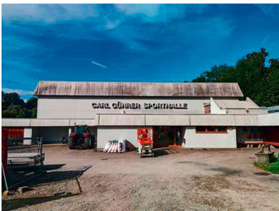
Die Sportstättenförderung für Tettngang bezieht sich auf die Dachsanierung der Carl-Gührer-Halle. Foto: Stadt Tettngang
