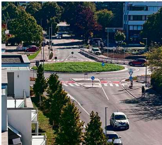
Die bevorrangten Radwege des Kreisverkehrs Oberhof-Schäferhof sind zur Erkennung rot gestaltet. Foto: Stadt Tettang
