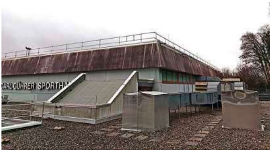
Neues Dach für die Carl-Gührer-Halle: Die Stadt Tettang hat die Dachabdichtung und Dämmung erneuert und damit den Werterhalt sowie die Energieeffizienz des Gebäudes verbessert.
