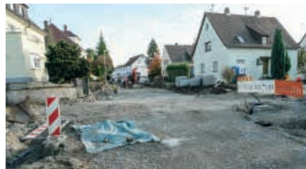
Bauarbeiten in der Goethestraße
